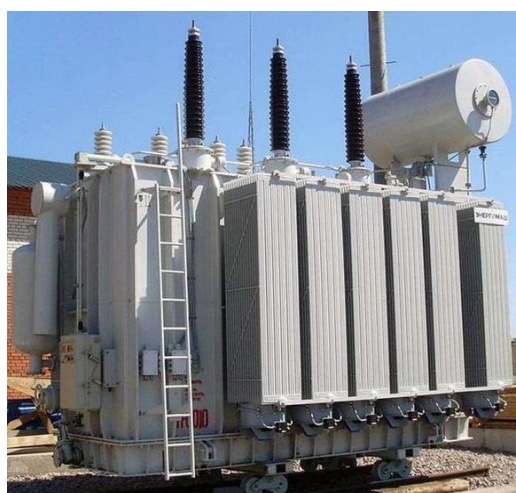
Рисунок 2.1.4 – Масляное охлаждение с дутьем и принудительной циркуляцией масла через воздушные охладители
