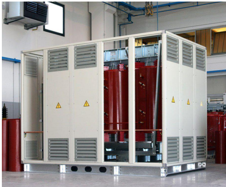
Рисунок 2.1.3 – Пример выполнения установки трансформатора внутри здания.
