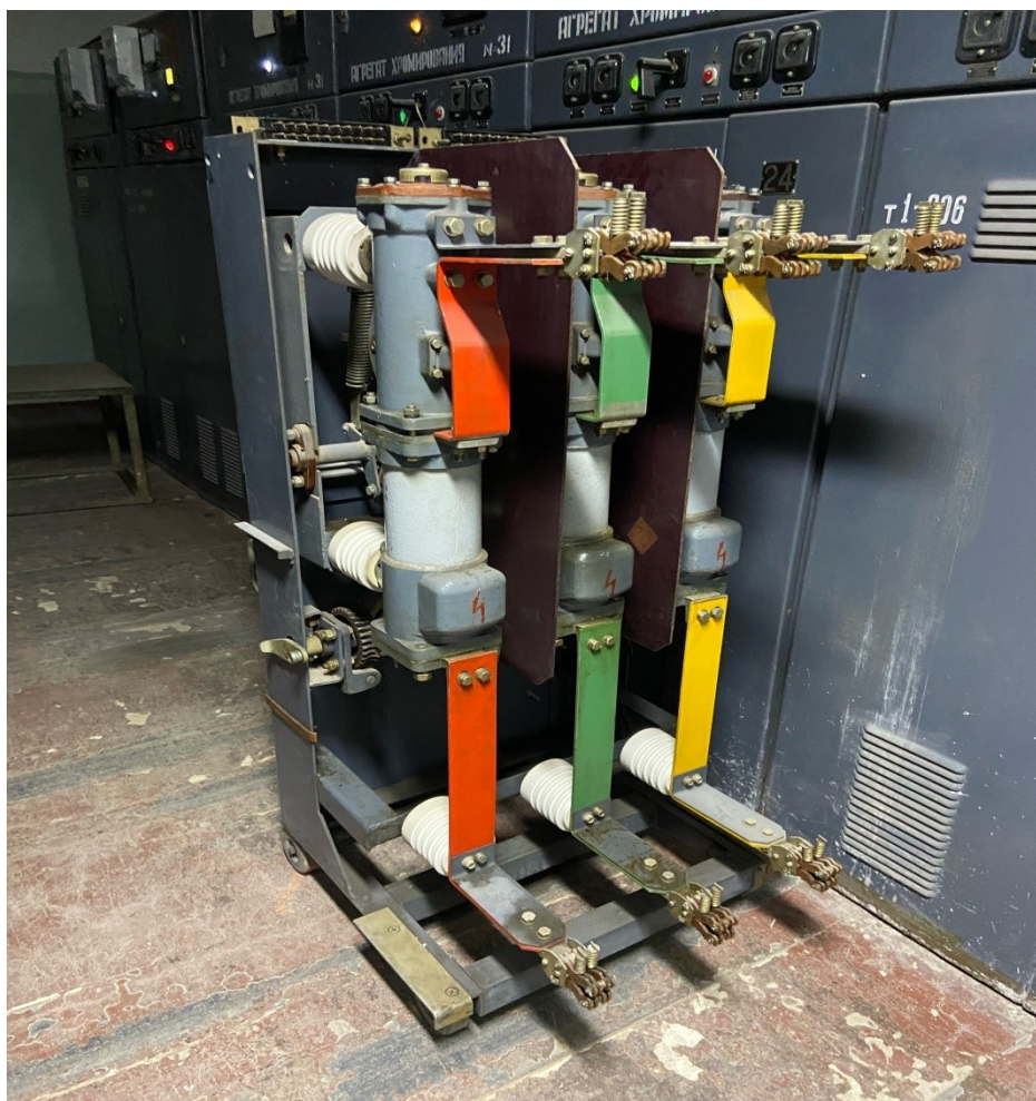
Рисунок 1.1.7 – Внешний вид масляного выключателя типа ВМП-10-630-20К
