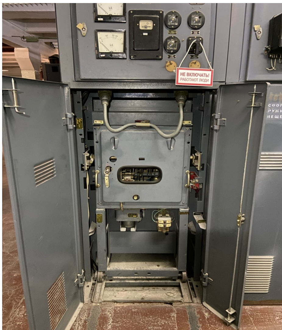
Рисунок 1.1.3 – Внешний вид ячейки типа КСО серии 272
